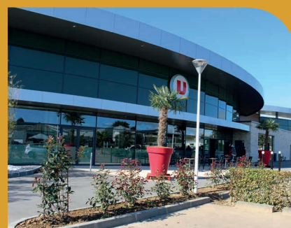
Fin des travaux d'extension du magasin Super U
