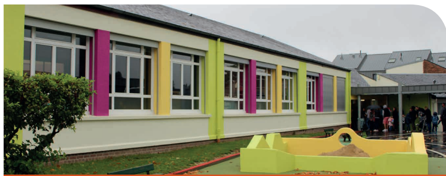
Ravalement des façades de l'école maternelle Louis Lemonnier
