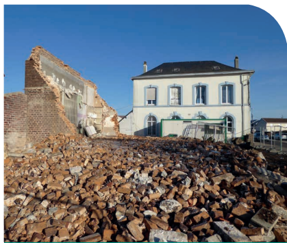
Les travaux de démolition sont achevés
