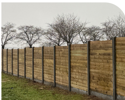
Réfection Clôture Bois-Béton du Cimetière
