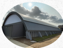
Gymnase et Studio de Danse Nicolas Fleury rue Guynemer Franqueville-Saint-Pierre
