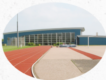
Gymnase et stade du Lycée Galilée rue de Belbeuf Franqueville-Saint-Pierre
